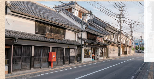
土蔵造りの旧製糸家の建物や大壁造りの商屋など、古い町並みが残る(本町通り)
